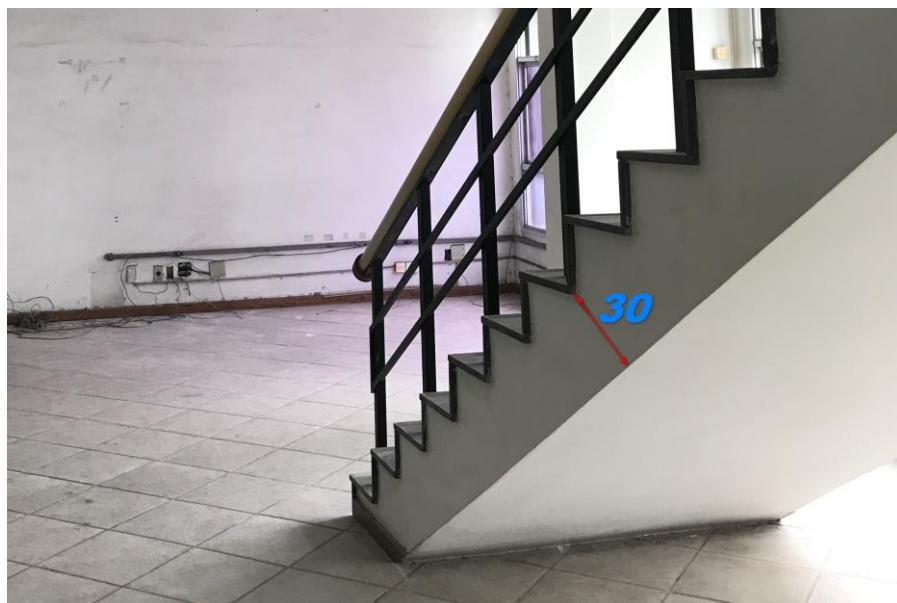
Foto 3 – Medida da espessura da laje da escada
