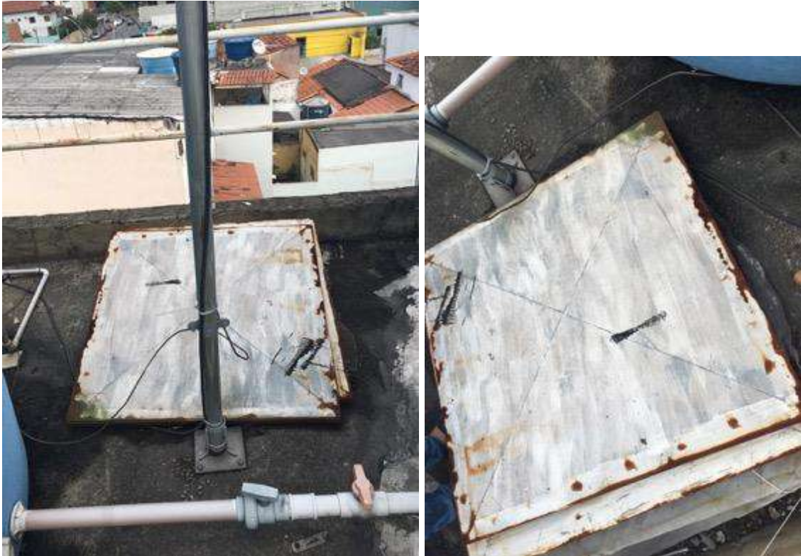
Figuras 28 e 29 – tampa da caixa d'água
