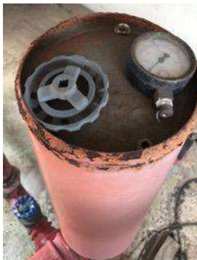
Figura 15 – cilindro de pressão (pulmão)
