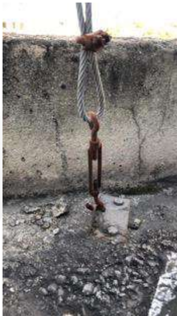
Figuras 5 e 6 – Sistema de fixação enferrujado
