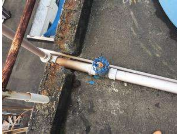
Figura 24 – rasgo para instalação provisória
