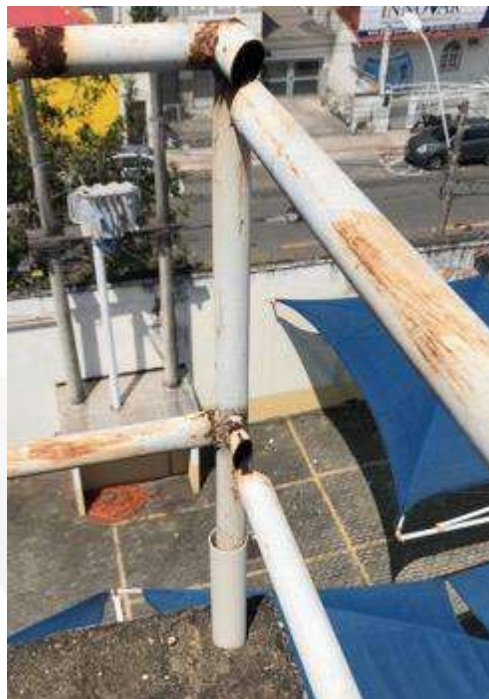
Figura 27 – guarda-corpo cortado
