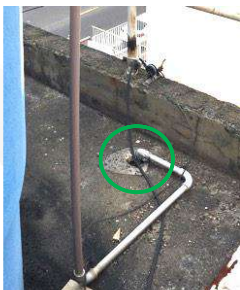
Figura 24 – furo na laje para instalação provisória
