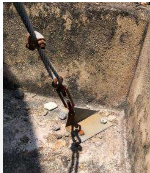
Figuras 5 e 6 – Sistema de fixação enferrujado
