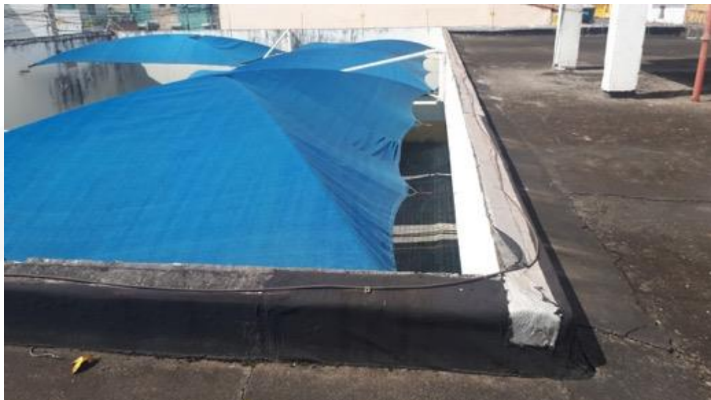
Figura 48 – estrutura metálica da cobertura da garagem
