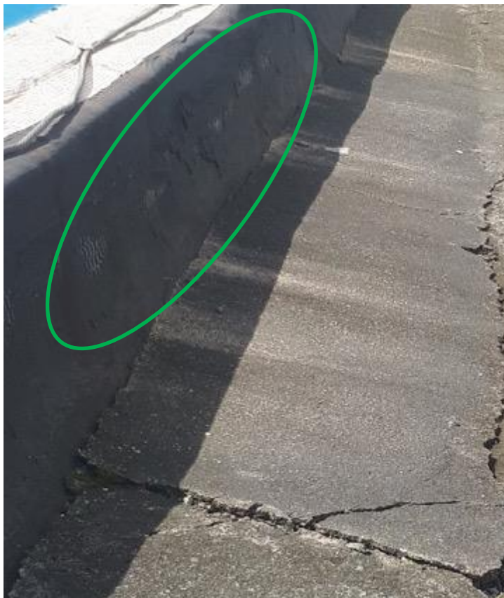
Figura 43 - impermeabilização danificada
