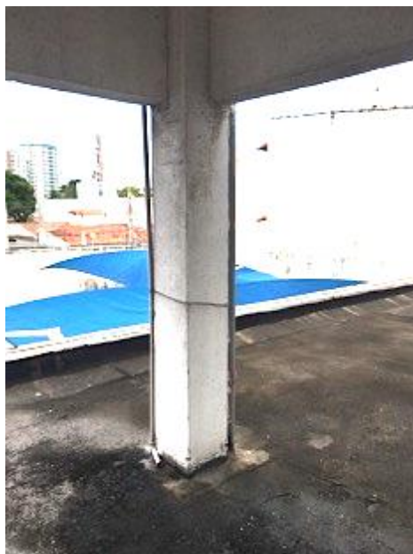
Figura 36 – saída de transbordo do abastecimento provisório
