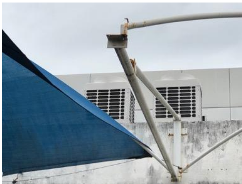
Figura 49 – estrutura metálica da cobertura da garagem
