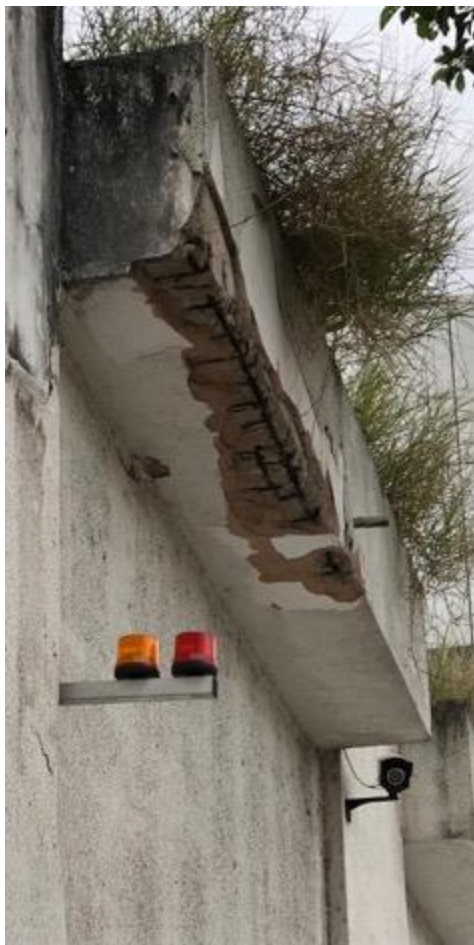
Figuras 67 e 68 – jardineira externa com patologia estrutural
