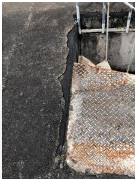
Figura 42 – manta danificada
