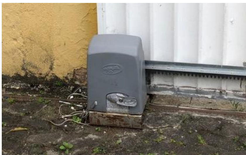
Figura 61 – gambiarra elétrica
