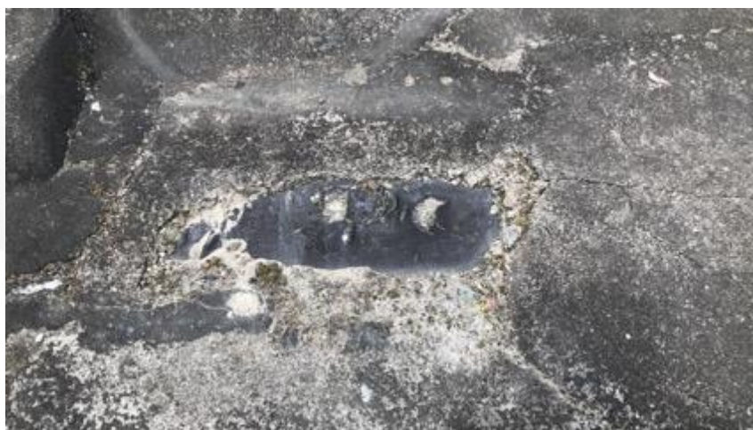
Figura 44 – impermeabilização danificada
