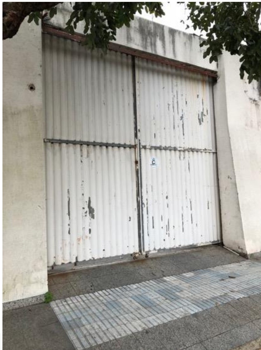
Figura 62 – foto externa do portão
