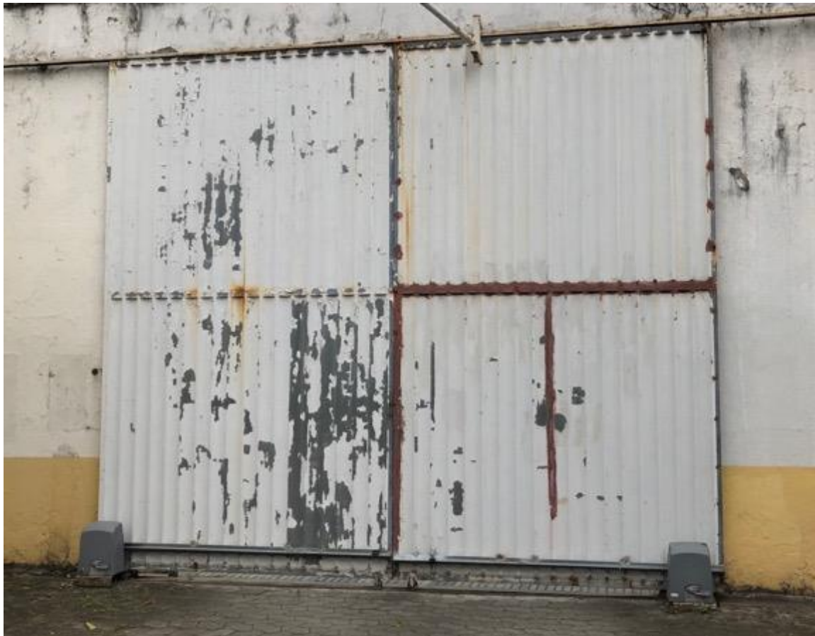
Figura 57 – foto interna do portão da garagem
