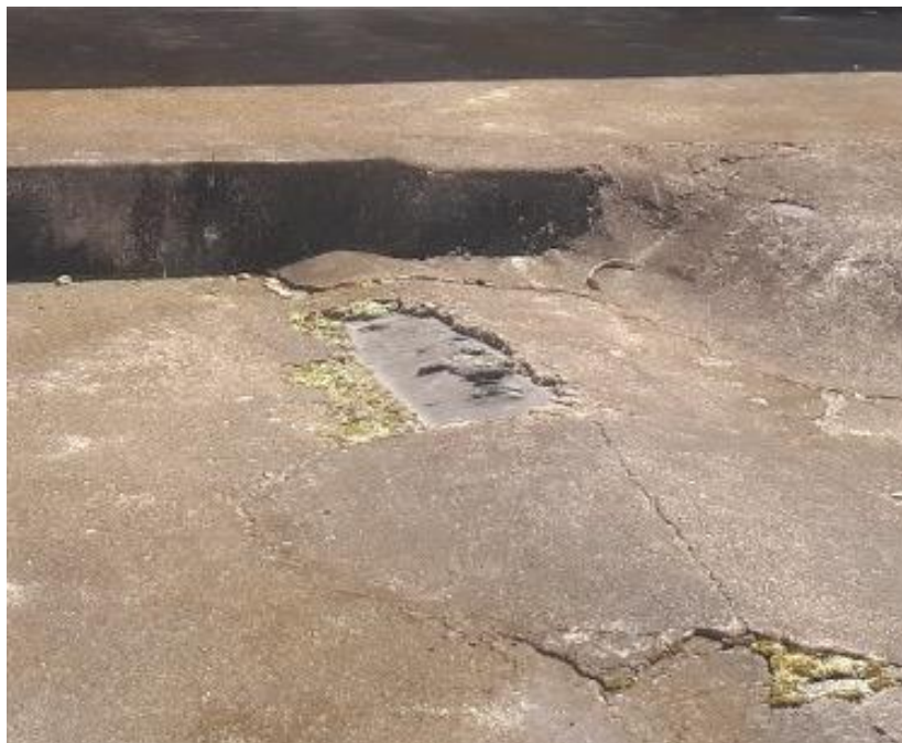
Figura 45 – impermeabilização danificada
