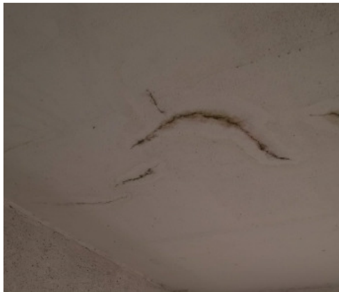
Imagens 7 e 8 – Fissura não estrutural abaixo da laje piso do barrilete
