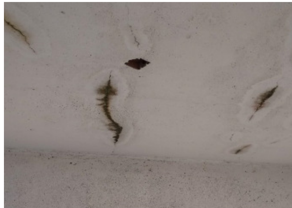
Imagens 7 e 8 – Fissura não estrutural abaixo da laje piso do barrilete
