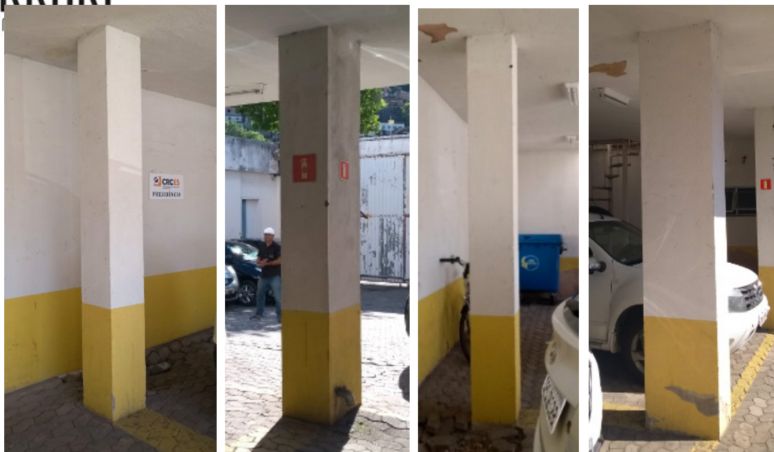
Imagens 13, 14, 15 e 16 – Pilares de sustentação do castelo d'água sem trincas ou rachaduras.
